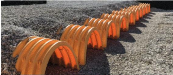
Rellenar uniformemente entre las hileras y alrededor del perímetro hasta que la grava alcance la parte superior de las cámaras. Extender la grava perimetral horizontalmente a los muros de excavación, tanto en las paredes laterales rectas como en las inclinadas. Después de acostillar las cámaras hasta la parte superior y cubrirlas con al menos 150 mm (6") de grava, se permite el uso de pequeñas excavadoras para el relleno final sobre las cámaras.
