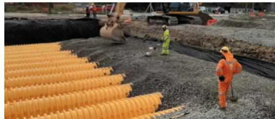
Durante esta etapa de instalación, se prohíbe cualquier operación de equipos sobre las cámaras. Las excavadoras deben ubicarse fuera de la zanja y los camiones de volteo no deben descargar grava directamente sobre las cámaras. Además, se restringe el acceso de excavadoras y cargadores a la zanja en este momento.
