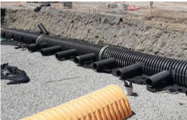
Coloca y conecta los manifolds en la zanja. Utiliza geotextil tejido en filas de entrada de al menos 3.8 m (12.5 pies) en cada tapa. Coloca una pieza continua de geotextil a lo largo de la Hileras Aisladora, sin traslapes ni doble capa.
