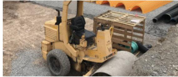
Se pueden utilizar excavadoras de oruga y miniexcavadoras para completar el relleno de piedra de acuerdo con los límites de presión del suelo establecidos en la Tabla 2. Es importante que empujen el material en paralelo a las hileras y eviten hacerlo de forma perpendicular. Se recomienda que el contratista inspeccione las cámaras antes de finalizar el relleno y cualquier cámara dañada durante la construcción debe ser reemplazada.
