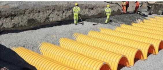
Continúa el relleno uniforme entre las filas y alrededor del perímetro hasta que la grava alcance la parte superior de las cámaras. Asegúrate de que la grava perimetral se extienda horizontalmente hasta los muros de excavación, tanto en las paredes laterales rectas como inclinadas.
