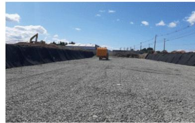
Coloca una base de grava limpia y triturada de 150 mm (6") de espesor como mínimo. Compacta para obtener una superficie plana.
