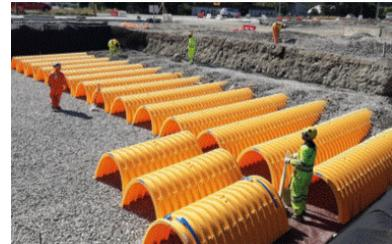
Continúa instalando las cámaras superponiendo las corrugaciones de los extremos entre cada cámara. Las juntas de las cámaras están etiquetadas como "Lower Joint – Overlap Here" y "Build this direction – Upper Joint". Asegúrate de que la colocación de la cámara no exceda el alcance del equipo de construcción utilizado para colocar la grava. Mantenga un espacio mínimo de 150 mm (6") entre cada hilera.
