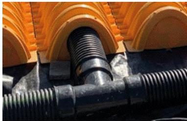
Alinea las primeras tapas y cámaras de cada fila con los tubos de entrada. El contratista puede optar por postergar la colocación de grava alrededor de las cámaras finales y dejar los extremos de las filas abiertos para inspeccionar fácilmente las cámaras durante el proceso de relleno.
