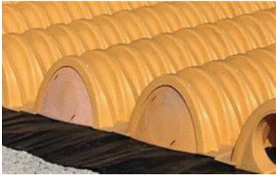
Levante el extremo de la cámara unos cuantos centímetros del suelo. Con la cara curva de la tapa hacia afuera, coloque la tapa en el último corrugado del interior de la cámara.
