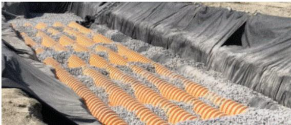
Inicia el acostillado desde la línea central de una cámara y extiéndelo a lo largo de toda su longitud utilizando un lanzador de grava ("shooter") o una excavadora de alcance suficiente.
