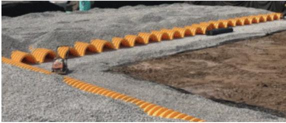
Continúa relleno uniformemente entre las filas y alrededor del perímetro hasta que la grava alcance la parte superior de las cámaras. Extiende la grava perimetral hasta los muros de excavación, tanto en las paredes rectas como inclinadas.
