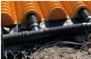
Coloca y conecta los manifolds en la zanja. Utiliza geotextil tejido en filas de entrada de al menos 3.8 m (12.5 pies) en cada tapa. Coloca una pieza continua de geotextil a lo largo de la Hileria Aisladora, sin traslapes ni doble capa.
