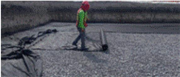
Instale geotextil no tejido sobre la grava. El geotextil debe traslaparse a un mín. de 600 mm (24") donde los bordes se encuentran. Compacte cada levantamiento de relleno. El rodillo debe moverse en paralelo con las filas.
