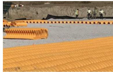
Continúa instalando las cámaras superponiendo las corrugaciones de los extremos entre cada cámara. Las juntas de las cámaras están etiquetadas como "Lower Joint – Overlap Here" y "Build this direction – Upper Joint". Asegúrate de que la colocación de la cámara no exceda el alcance del equipo de construcción utilizado para colocar la grava. No se requiere espacio entre las cámaras.
