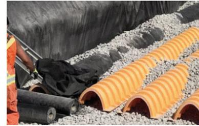
Coloque una capa de geotextil no tejido sobre la fila de cámaras que compone la hilera aisladora. Asegúrese de que la tela quede plana y se extienda por todo el ancho de los pies de las cámaras.
