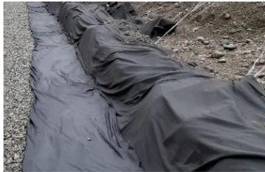
Coloca el geotextil no tejido sobre la superficie de la zanja, incluyendo los taludes y muros. Agrega subdrenajes inferiores si es necesario.
