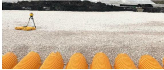
Puedes utilizar pequeñas excavadoras y cargadoras de deslizamiento para nivelar el relleno de grava, siguiendo los límites de presión del suelo de la Tabla 2. Asegúrate de empujar el material solo de manera paralela a las hileras, evitando hacerlo de forma perpendicular. Antes de colocar el relleno final, se recomienda que el contratista inspeccione las cámaras. Cualquier cámara dañada durante la construcción debe ser removida y reemplazada según las recomendaciones de ADS Mexicana.
