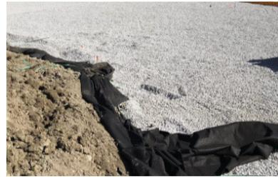
Coloca grava limpia y triturada según el espesor requerido o utiliza Geogrid BX124GG. Compacta para obtener una
