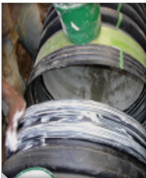
Figura 14. Colocación de lubricante.
