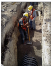
Figura 18. Compactación de relleno inicial.
