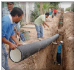
Figura 8. Bajado manual de tubería a la zanja.
