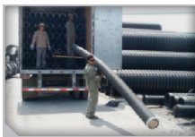
Figura 1. Descarga manual de tubería hasta 18 pulgadas.
