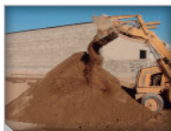
Figura 15. Humedad óptima al material de acostillado.
