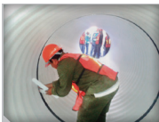
Figura 13. Verificación de posición de empaques con lana plástica por el interior y exterior.
