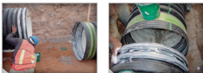
Figura 10. Limpieza en espiga e interior de campana y aplicación de lubricante.
