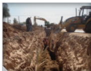
Figura 16. Colocación y compactación simétrica por capas.
