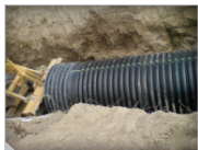
Figura 12. Empuje con maquinaria.
