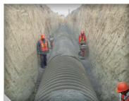
Figura 16. Colocación y compactación simétrica por capas.
