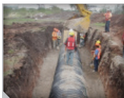
Figura 16. Colocación y compactación simétrica por capas.
