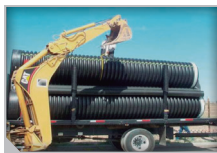
Figura 2. Descarga con maquinaria de 24 a 60 pulgadas.
