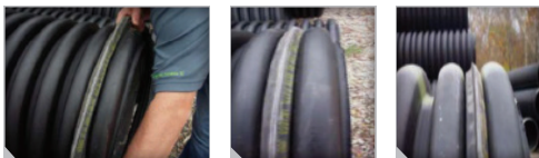
Figura 21. Colocación de empaques de valle.
