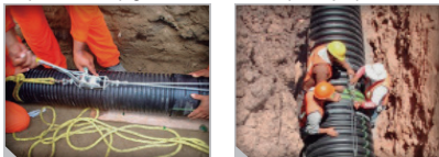
Figura 11. Inserción de espiga en campana con el uso de polipastos (conocidos como tecles o tirfor).
