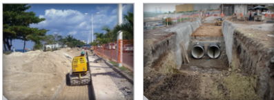
Figura 19. Compactación relleno final.
