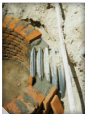
Figura 20. Conexión a pozo con empaques de valle.
