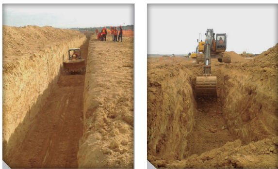
Figura 5. Excavación de la zanja.
