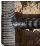
Figura 23. Conexión lateral hermética con Tee-In de 8 x 6 pulgadas.
