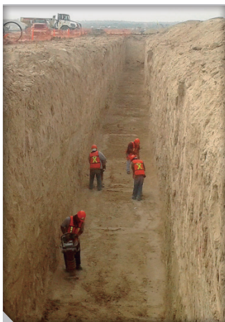
Figura 7. Compactación de encamado con equipo portátil.
