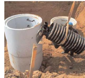
Instale la unidad BaySeparator™ y conecte sus tuberías
