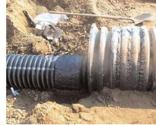
Conecte el adaptador con la tubería de salida
