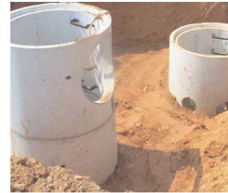
Realice el relleno alrededor de los pozos de visita hasta los niveles de arrastre de tubería
