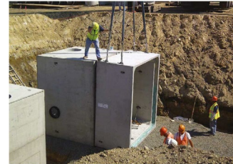
Montaje de bóveda modular
