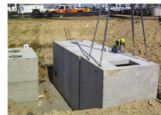
Sección final de la bóveda
