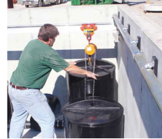
Colocación del filtro
