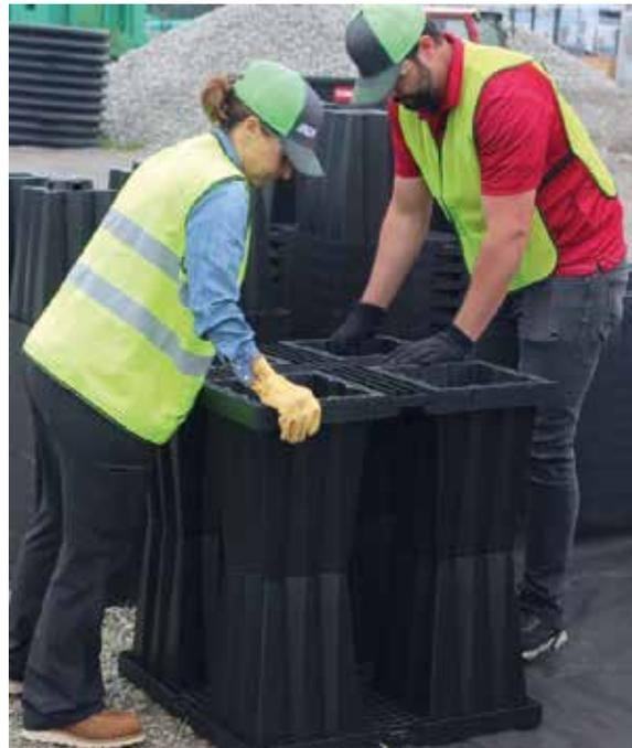
Durante la instalación, es posible caminar sobre la parte superior de los módulos Aquabox. Está prohibido que máquinas en funcionamiento, incluso las pequeñas, pasen sobre la estructura sin la cobertura adecuada.
