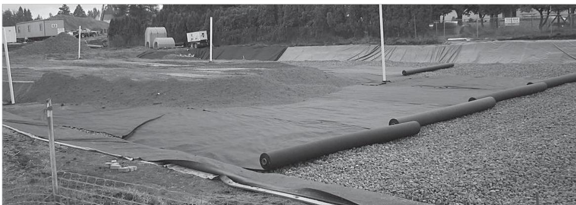
Instale geotextil no tejido sobre la grava. El geotextil debe traslaparse 600 mm (24") donde se encuentren los bordes.
