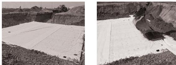
Rellene de manera uniforme alrededor del perímetro hasta que la grava de relleno alcance la parte superior de los módulos y haya un mínimo de 150 mm (6") de grava sobre el sistema. El método recomendado de relleno es con una excavadora desde fuera del lecho.
