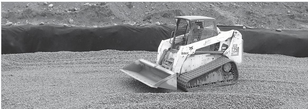
Solo después de que los módulos hayan sido rellenos con un mínimo de 150 mm (6") de grava encima de los módulos, se pueden usar cargadores de orugas o cargadores pequeños para nivelar definitivamente la grava y el relleno final, de acuerdo con los límites de presión sobre el suelo en la Tabla 2.
