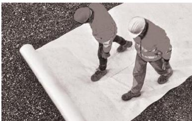
Coloque una segunda capa de geotextil no tejido sobre la capa de piedra base y a lo largo de las paredes de la excavación. Esta capa de geotextil envolverá el módulo Aquabox y evitará que la piedra entre en el sistema.
