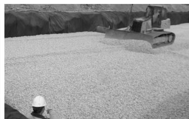
Excave el lecho y prepare el terreno de desplante según los planos del ingeniero. Los planos y especificaciones deben incluir Prácticas de Gestión Ambiental (BMPs, por sus siglas en inglés) para evitar la contaminación de las excavaciones abiertas durante la construcción.
