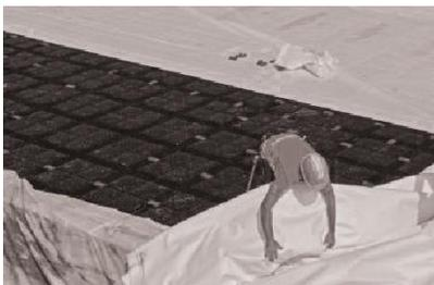
A continuación, proceda con la instalación de las paredes laterales Aquabox y Cube alrededor del exterior del sistema. Donde se planifiquen conexiones de entrada/salida, corte el panel lateral al tamaño adecuado antes de instalarlo en el sistema Aquabox.
