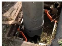
Vacíe o aspire la bolsa del filtro si hay demasiado sedimento o residuos.
