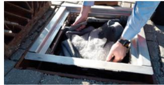
Embone su estructura de FlexStorm® de manera segura
