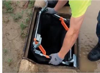
Embone su estructura de **FlexStorm**® de manera segura.
