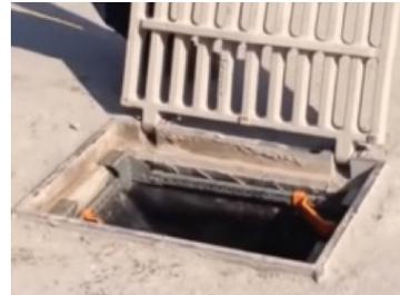
Coloque la rejilla con su filtro **FlexStorm**® limpio y en buenas condiciones.
